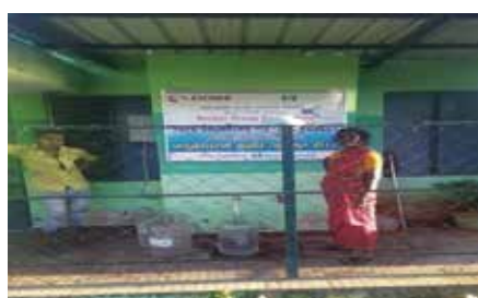
Community RO unit - Vattampakkam
